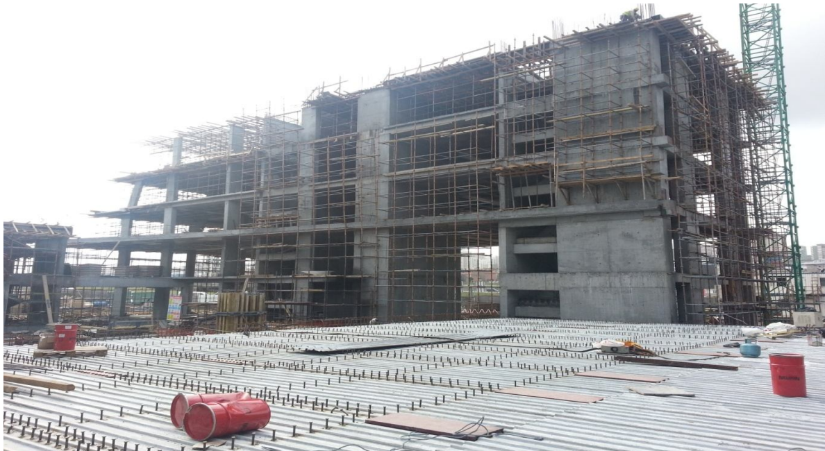
Otel inşaatı ilerleme durumu (Şubat 2013)
