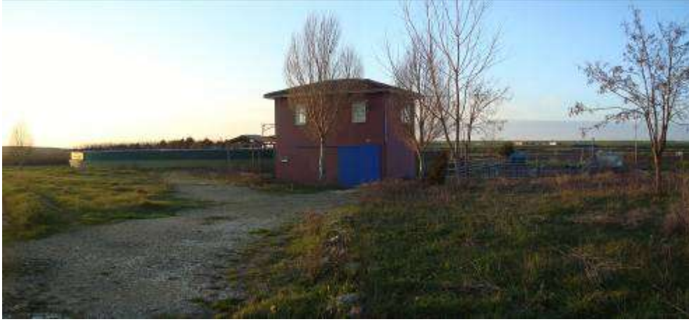
Arıtma Tesisi ve kontrol binası
