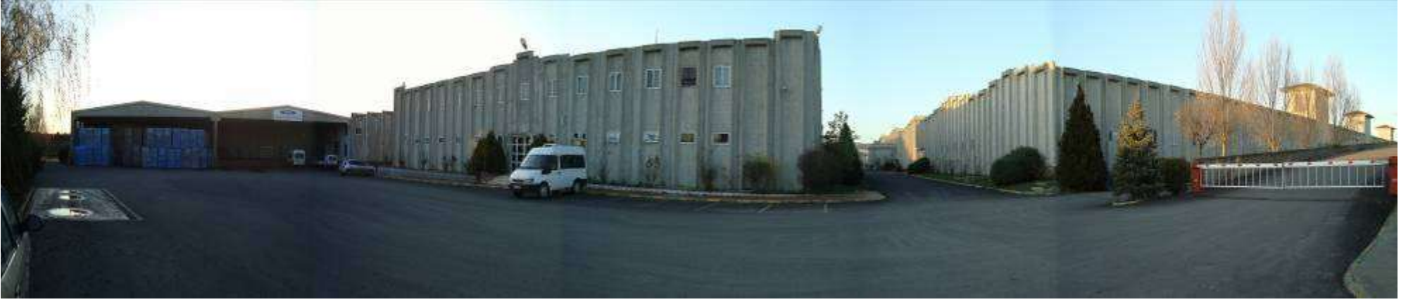
Tesisin girişten görünümü
