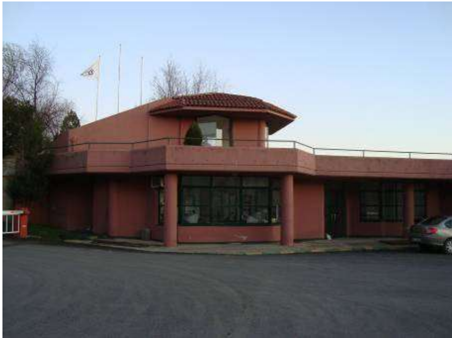
Güvenlik ve Personel giriş Binası
